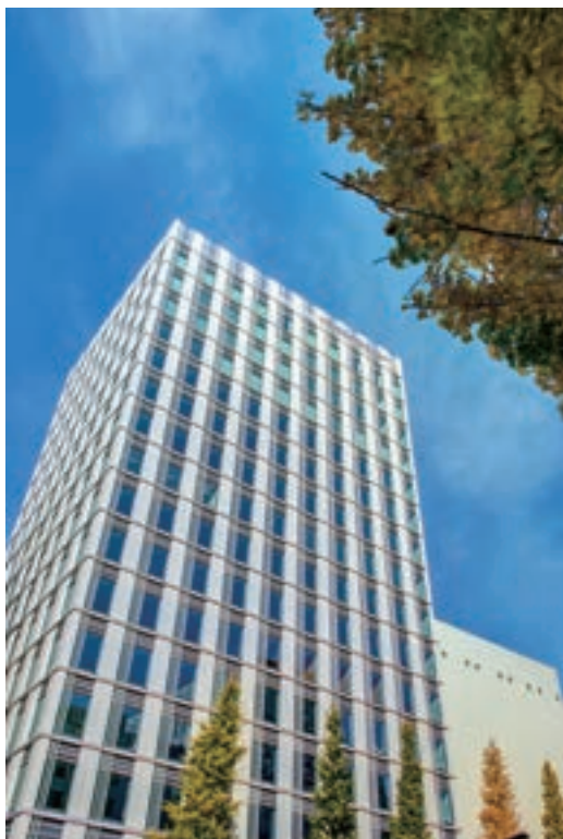
昭和通りに完成したオンワードパークビルディング
