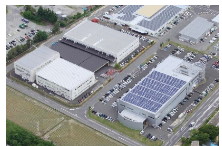
長野本社・物流拠点の全景
